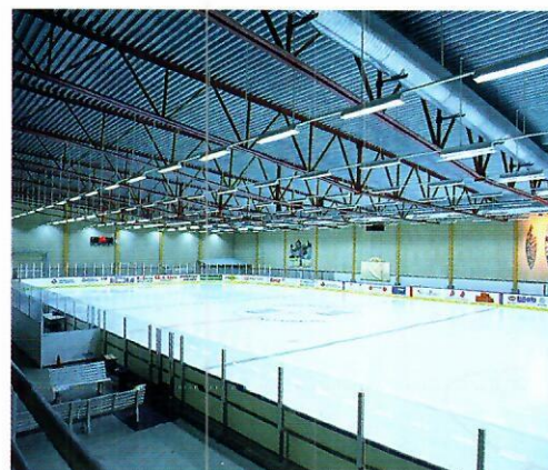
Die Kälteleistung dieser Eisbahn wird von einem SABROE-Flüssigkeitskühler geliefert.
